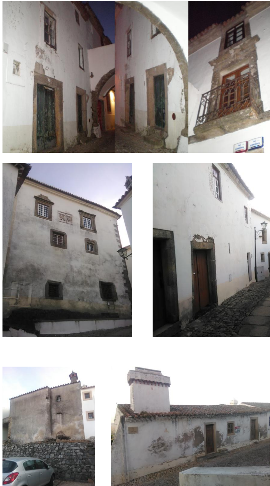
Figura 20. Imóveis em mau estado de conservação
