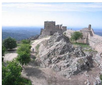
Fig. 2. Vista exterior do núcleo muralhado
