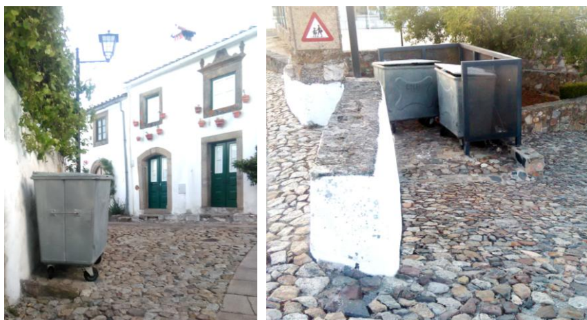
Fig. 28. Mobiliário urbano mal posicionado, em mau estado e inestético. (acrescentado em maio de 2015).
