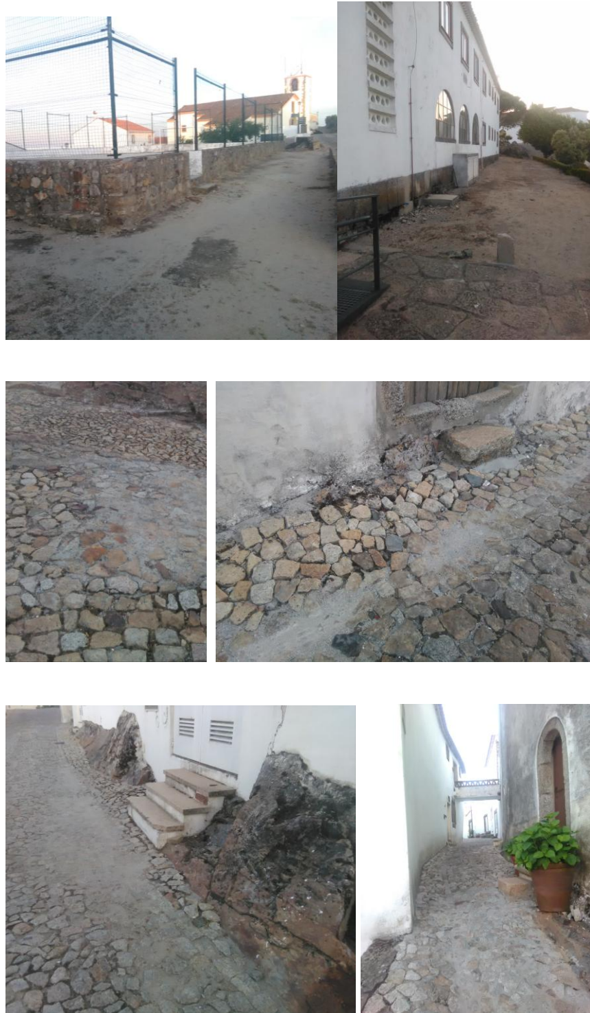
Figura 26. Pavimentos com conjugação desajustada de materiais e uso inadequado de cimento (acrescentado em maio de 2015)
