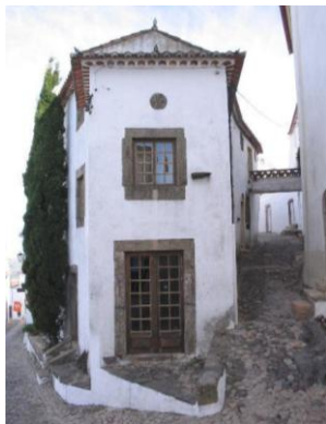
Fig. 9. Edifício da Rua das Portas da Vila
