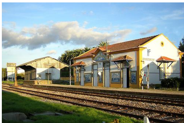
Figura 9. Estação de caminho-de-ferro de Marvão
