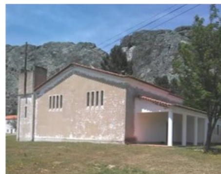
16 | Edifício da Capela
