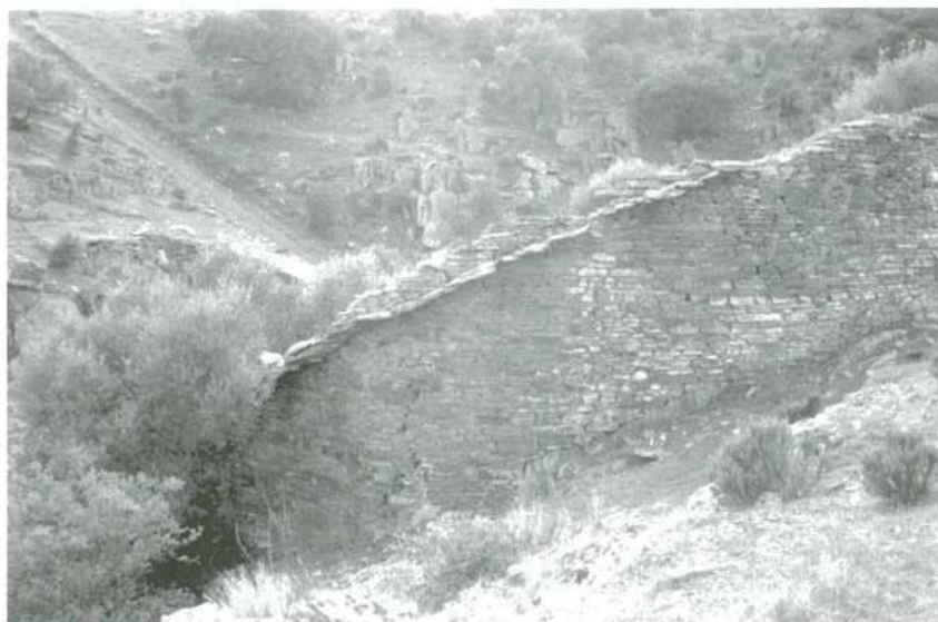
Fig. 10. Muro Alto (Idanha-a-Nova). Aspecto da estrutura do muro, construído em encosta muito inclinada. É visível um trecho do beirado existente no topo do muro.
