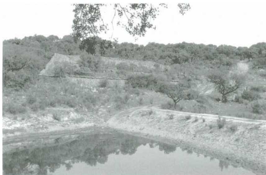
Fig. 4. Vista de conjunto do Muro do Vaz Preto.
