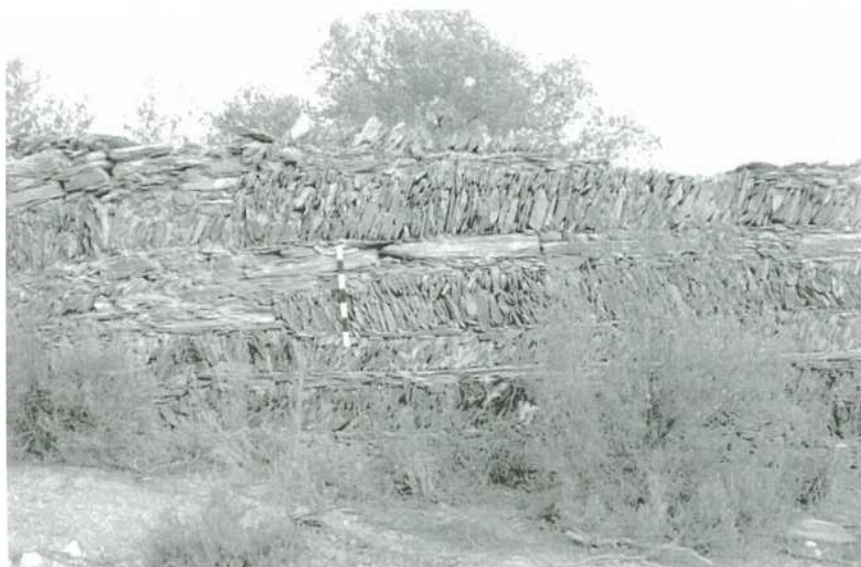
Fig. 3. Aspecto da estrutura em espinha do Muro do Romão.
