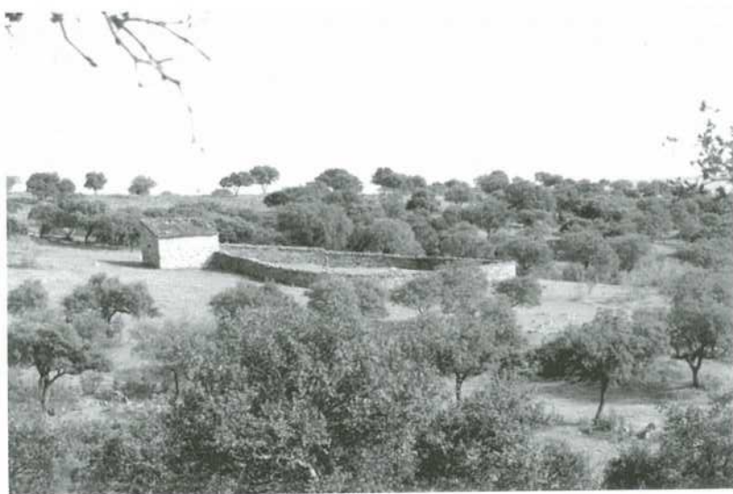
Fig. 12. Vista do muro de Alcantara I. Destaca-se a casa das alfaias melíferas.
