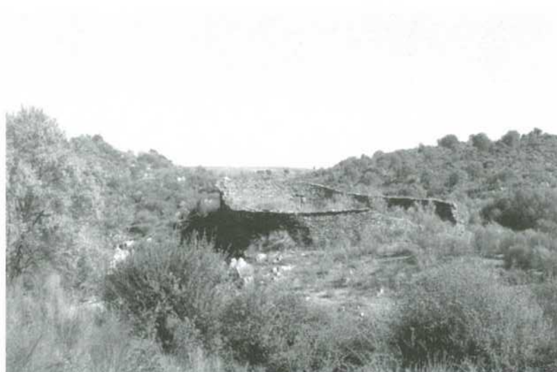
Fig. 6. Vista de conjunto do muro do Vale do Gamo.
