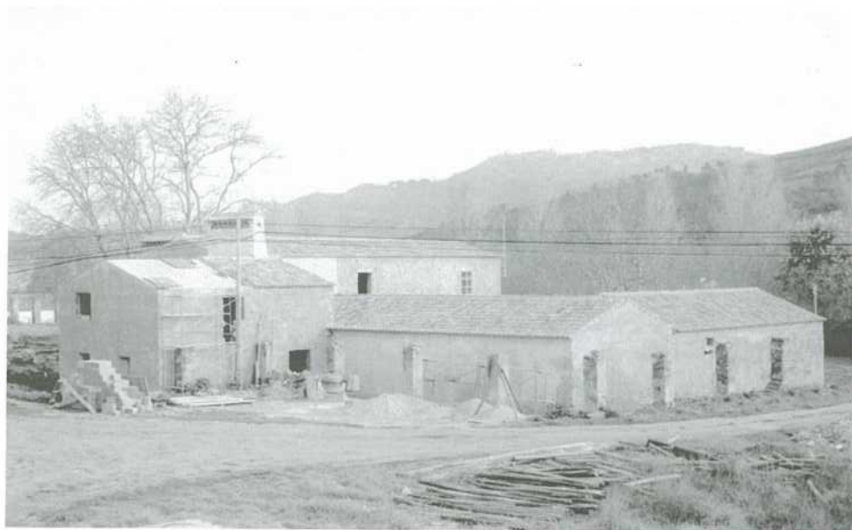
Figura 3 – Edifício da Quinta do Deão durante as obras de restauro.
