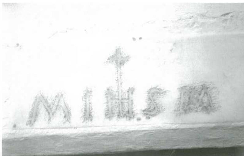
Foto 3- Alpalhão. Rua de S. Pedro, 20. Lintel
