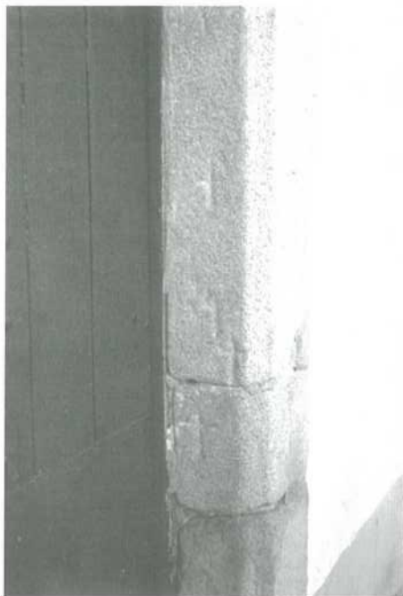
Foto 1- Alpalhão. Rua de S. to Antonio, 5. Ombreira direita interna
