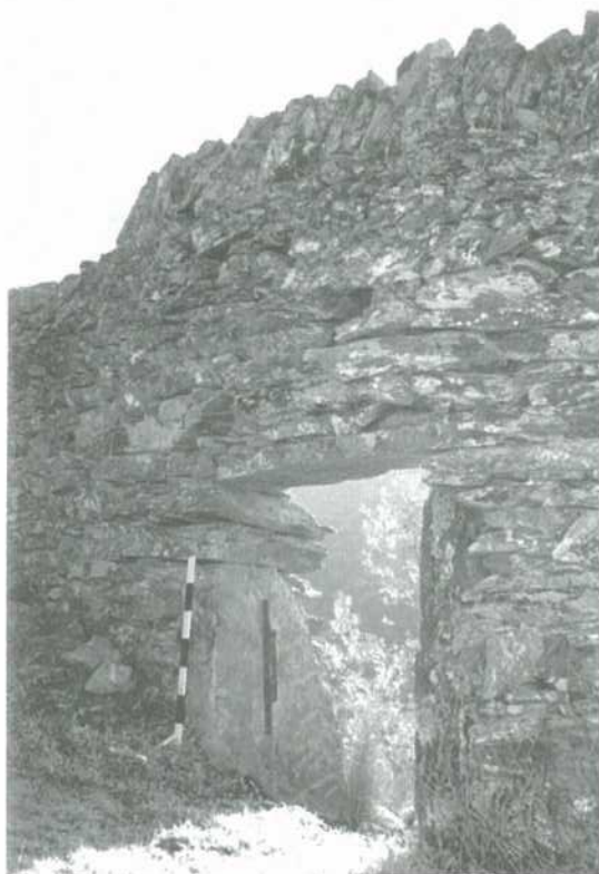
Fig. 5. Aspecto da porta do muro da Ponte da Munheca.
