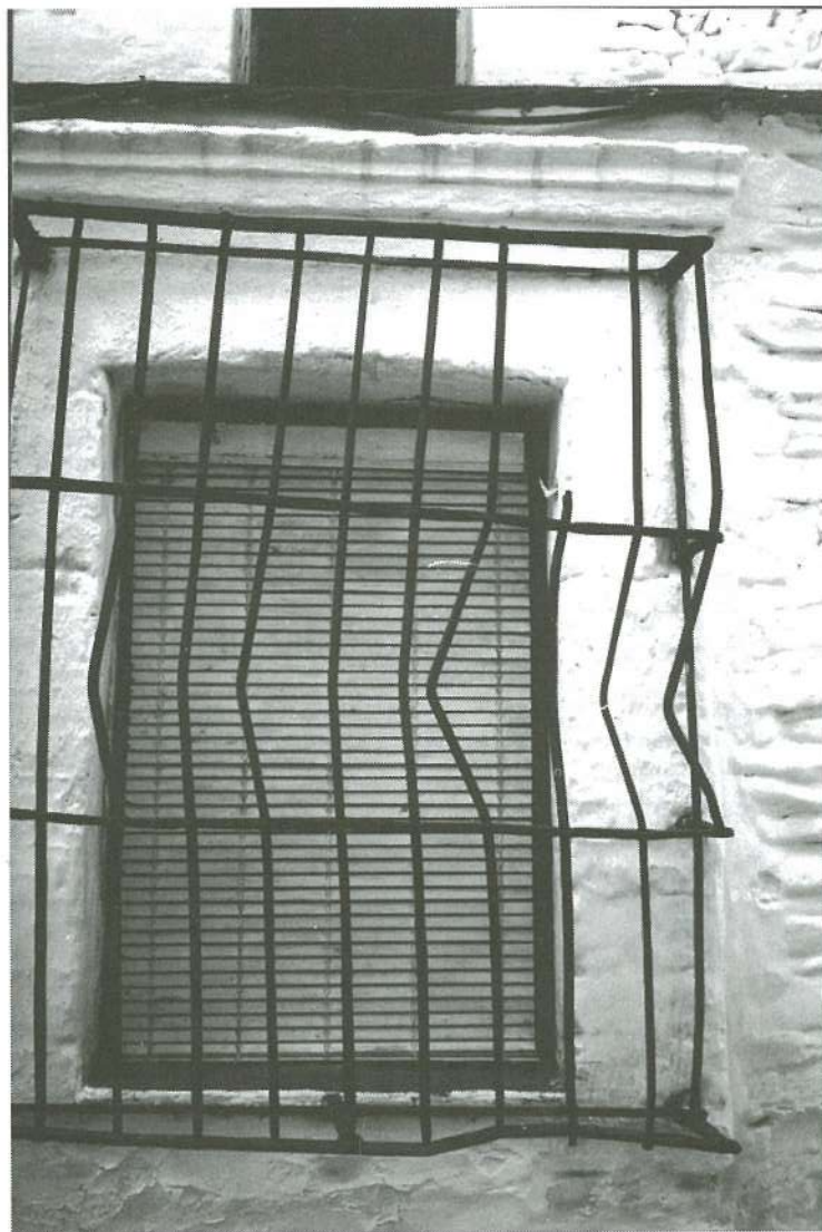
Encinasola. Cruz gravada na ombreira da janela da casa nº 3 na Calle Cinaga.
