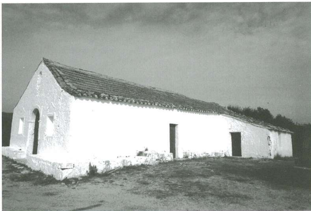
10. Aspecto da parede sul da capela e sacristia.
