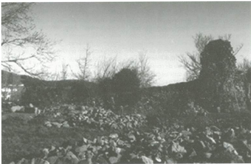
Vista da Torre antes dos trabalhos arqueológicos
