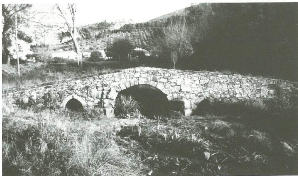
Ponte da Ribeira das Trutas (nº 76).
