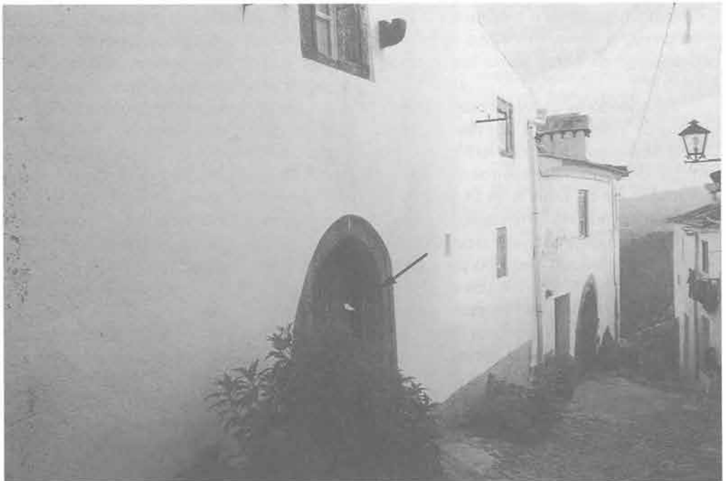
Ruinha da Judiaria, podendo identificar-se a casa onde terá habitado o arrabi da comunidade judaica. Marca na mezuzah na ombreira da porta
