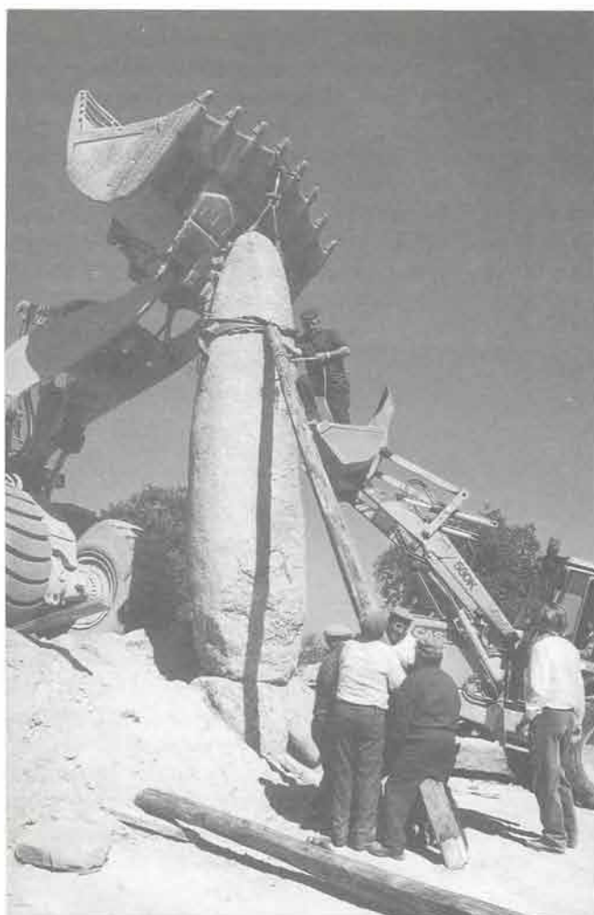
Foto 12 — Menir da Meada — Colcação dos apoios durante a operação de colagem
