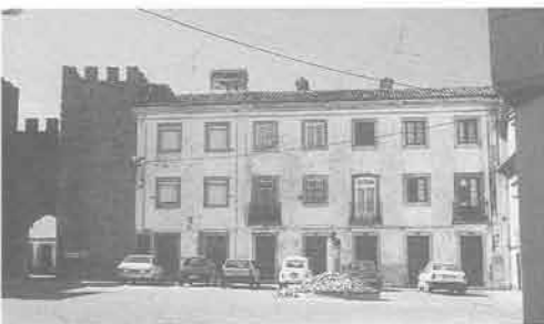
Largo da Porta da Vila frentes Oeste, Sul, Sul, e Norte (Foto J. Murta)
