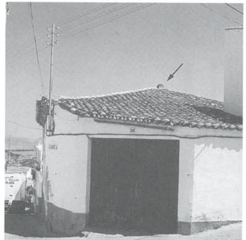
SINAGOGA DE VALÊNCIA DE ALCÂNTARA Identificação de base de coluna no topo do telhado.
