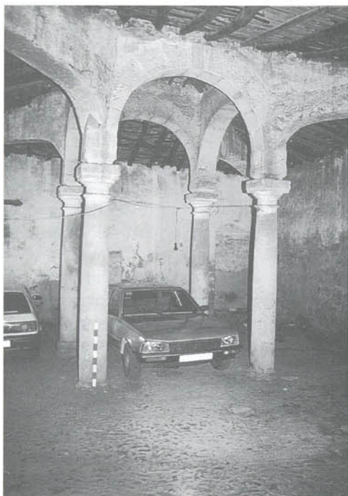
Vista geral do interior da Sinagoga de Valência de Alcântara
