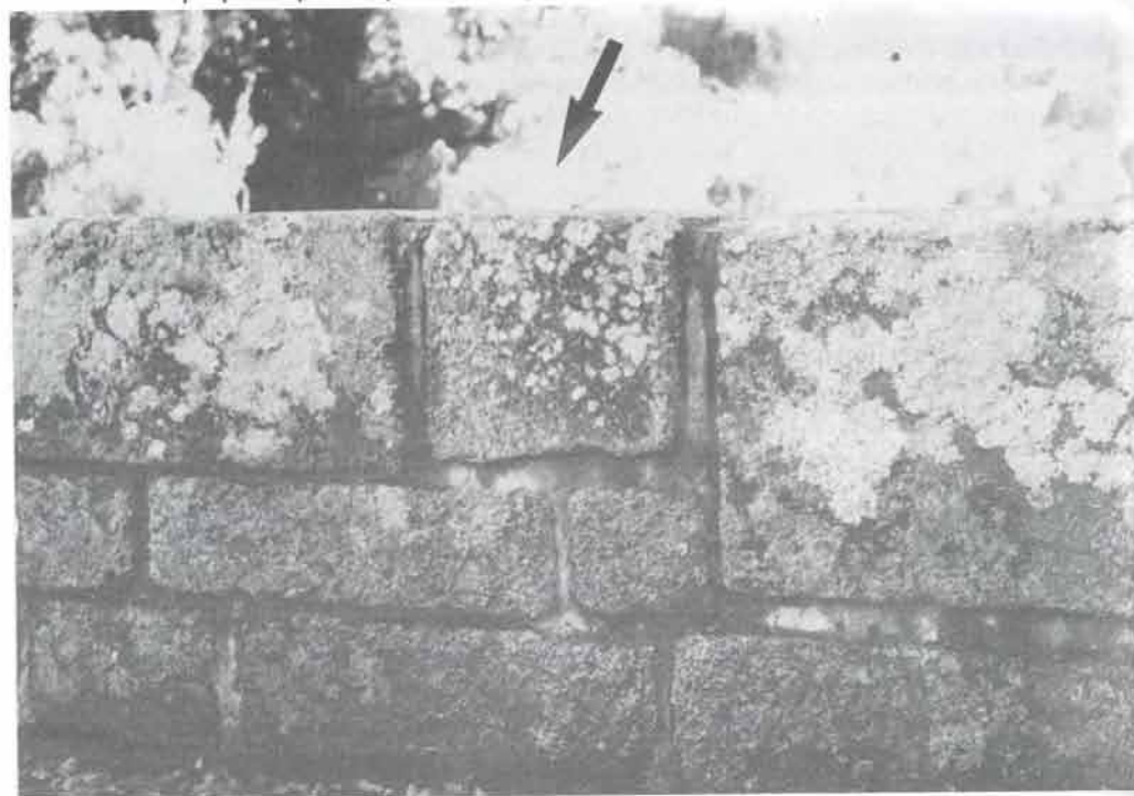
Bloco de granito recentemente colocado na guarda da Ponte da Portagem.
