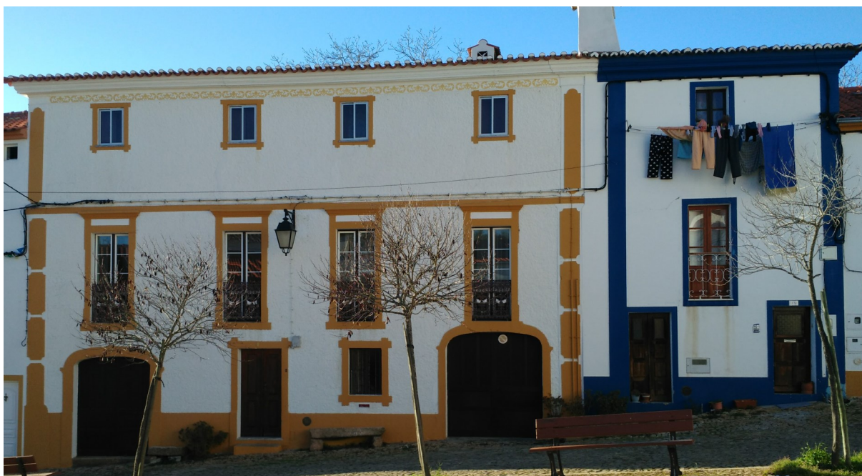
09 | Exemplo de vãos desalinhados
