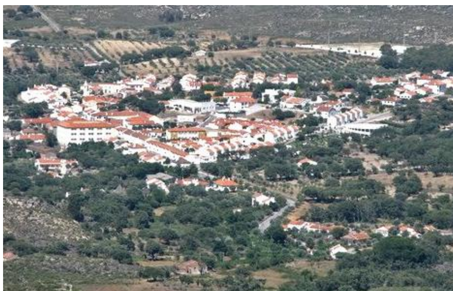
Figura 3. Vista do Edificado de Santo António das Areias
