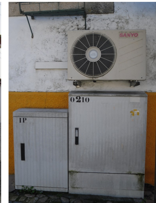
62 | Presença de elementos dissonantes
