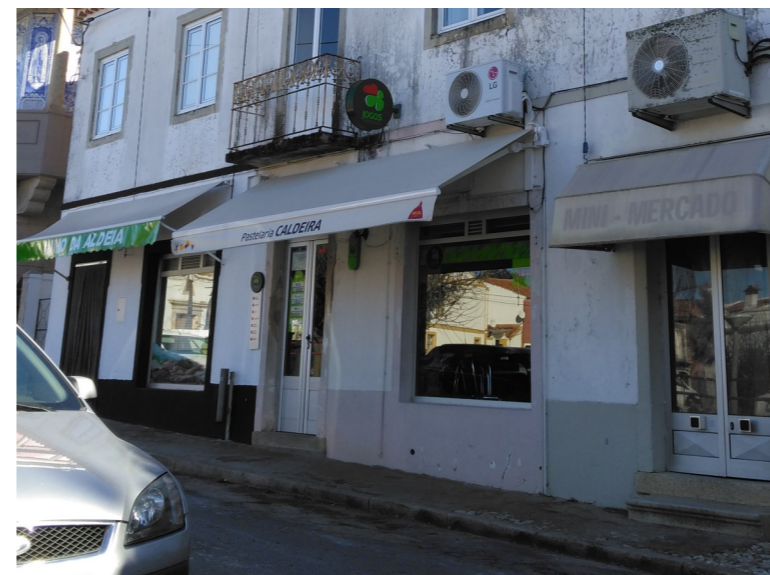
66 | Fachada com toldo de sombreamento
